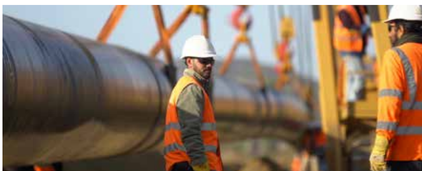
Строительство в северной Греции, ноябрь 2016 г.
